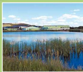
Das Niederschlagswasser wird einem großen Sammelbecken zugeführt und gelangt als Brauchwasser in die Intensivrotte. Dort dient es der Befeuchtung der organischen Fraktion. Kostbares Trinkwasser kann auf diese Weise eingespart werden.
