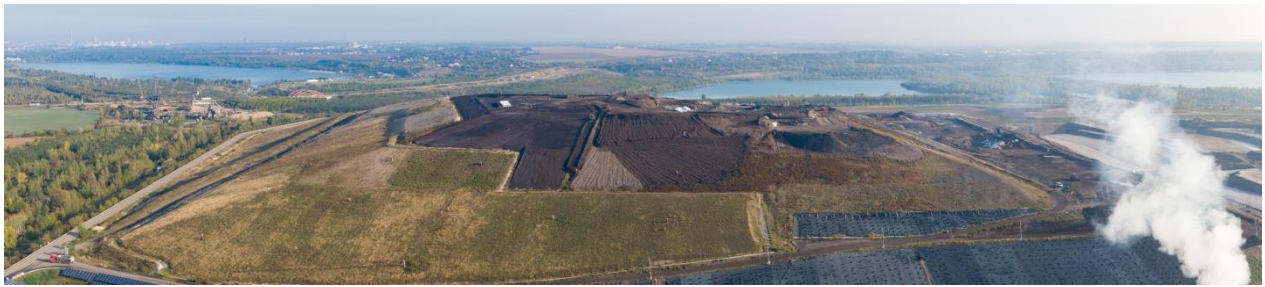
Abbildung 2 Zentraldeponie Cröbern (Foto: SCHAU! Multimedia)
